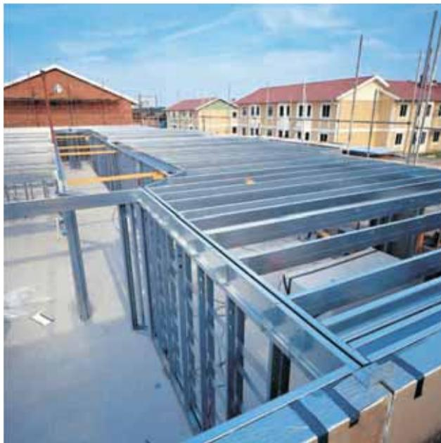
در جدول ۹ ظرفیت برشی دیوارهای کناف با دیوارهای بنایی مقایسه شده است. در این جدول ملاحظه می‌گردد که مقاومت برشی دیوارهای کناف با دیوارهای بنایی قابل مقایسه است. این در حالی است که وزن دیوارهای برشی کناف به مراتب از دیوارهای بنایی کمتر است.
