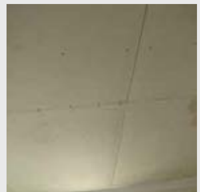
عدم رعایت حصرچینی در پنل‌ها
