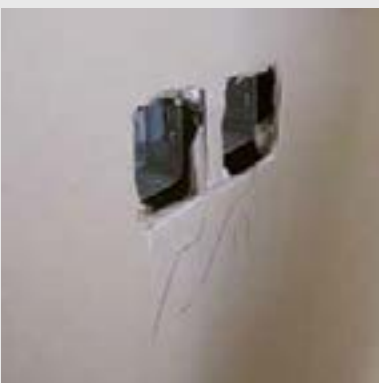
برش نامناسب پنل
