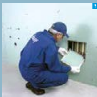
نصب قاب درب دریچه
