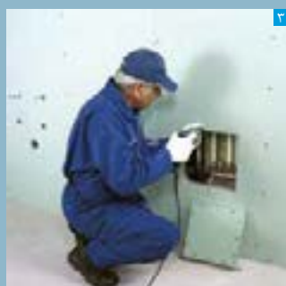
قرار دادن قاب اصلی دریچه درون دیوار و بیج کردن آن به پند
