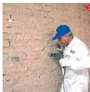
نصب قطعات سازه ای اتصال به دیوار
