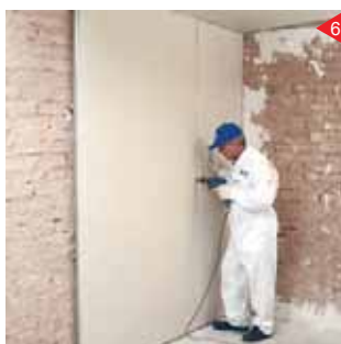
نصب صفحات روکش دار گچی بر روی زیر سازی فلزی
