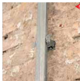
خم کردن بخش های بیرون زده از سازه اتصال به دیوار به سمت داخل
