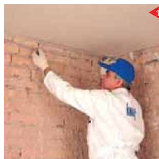
تعیین موقعیت رانر فوقانی بر روی سقف
