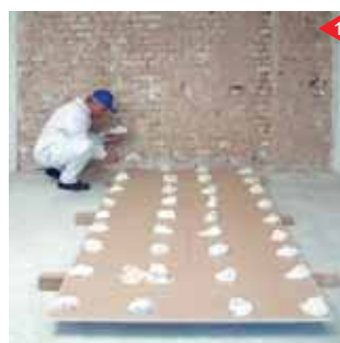
نشان دادن شانه های خمیر پرل فیکس در فواصل معین بر روی صفحات روکش دار گچی
