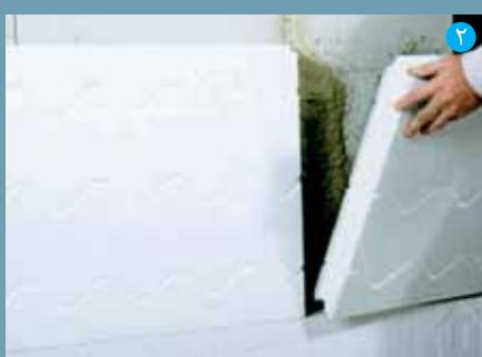
نصب قطعات عایق بر روی دیوار زمینه
