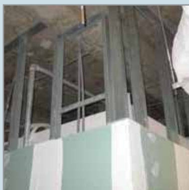
عدم امتداد یافتن پنل‌ها تا سقف اصلی
