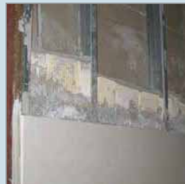
پر کردن فضای خالی دیوار با انواع مصالح صلب
