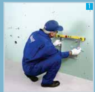
1 علامت گذاری محل نصب دریچه (با استفاده از قاب دریچه)
