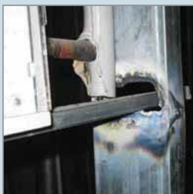
برش سازه با ابزار نامناسب
