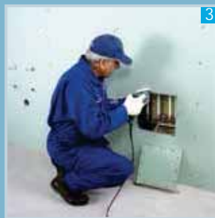
3 قرار دادن قاب اصلی دریچه درون دیوار و پیچ کردن آن به پنل
