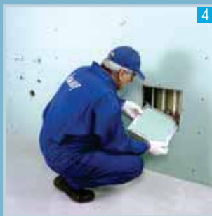
4 نصب قاب درب دریچه
