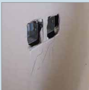
برش نامناسب پنل
