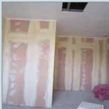
استفاده از بتونه و آماده سازی سطوح برای رنگ آمیزی به روش سنتی
